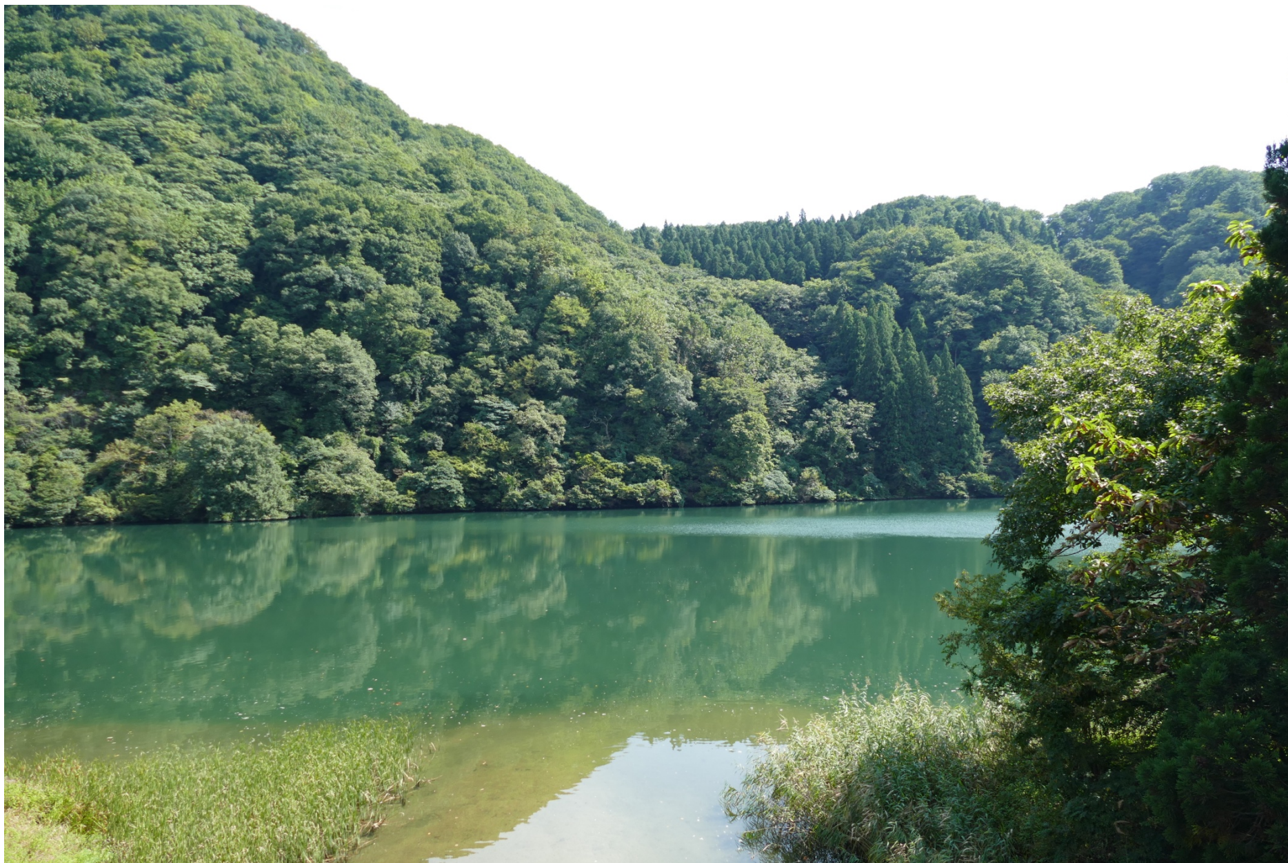
角神ダム鹿瀬発電所から200メートルほど上流地点
